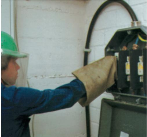
**Abb. 7: Herausnehmen eines NH-Sicherungseinsatzes**
