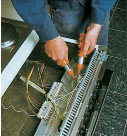
**Abb. 13: Feststellen der Spannungsfreiheit an einem Elektroherd**
