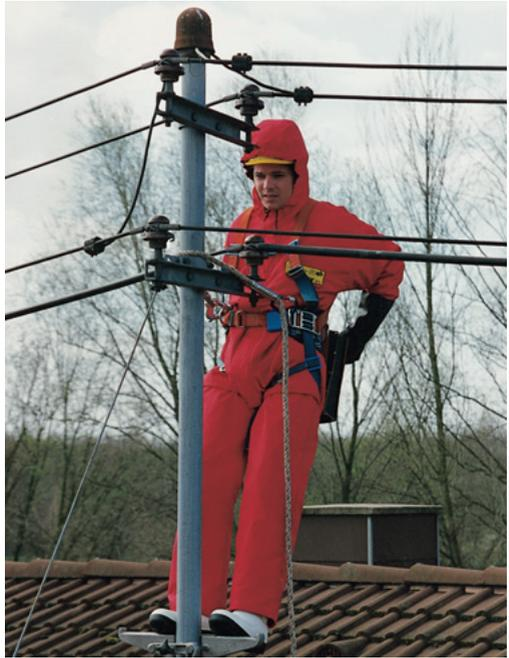
Abb. 19: Isolierte Schutzanzug
