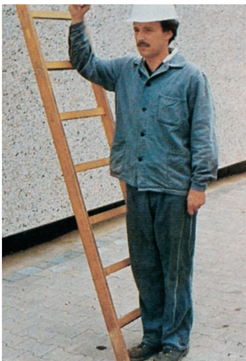
Abb. 30: Ermittlung des richtigen Anstellwinkels bei Anlegeleitern
