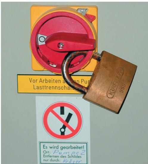
**Abb. 9: Hauptschalter mit Vorhängeschloss und Schaltverbotsschild gegen Wiedereinschalten gesichert**
