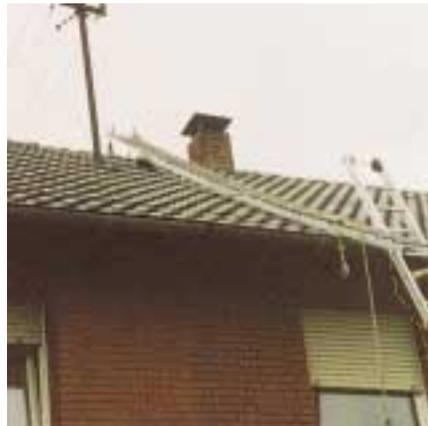
Bild 38: Das Gerät sichert den Monteur bei der erstmaligen und letzten Benutzung eines Verkehrsweges zum Arbeitsplatz wie auch am Arbeitsplatz gegen Absturz
