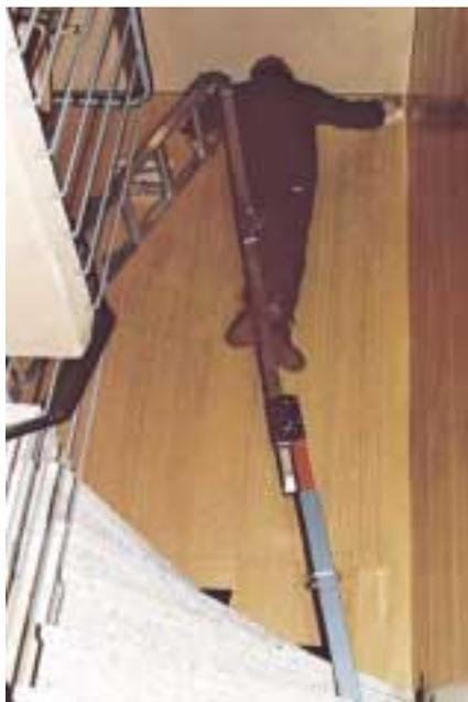
Bild 25: Leitern mit Verlängerungsteilen machen das Arbeiten im Treppenhaus möglich
