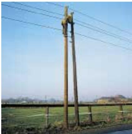
Bild 36: Der alte Mast darf nicht mehr bestiegen werden
