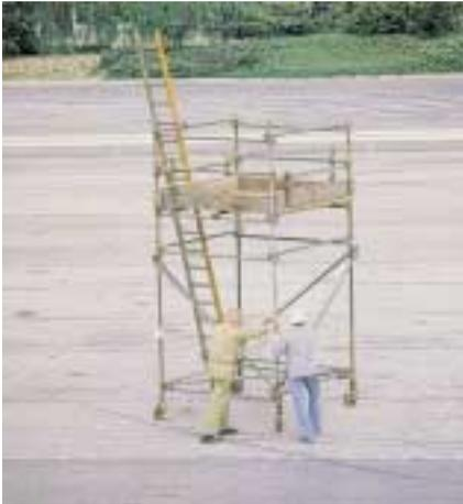
Bild 30: Fahrbares Gerüst nach DIN 4420 Teil 1
