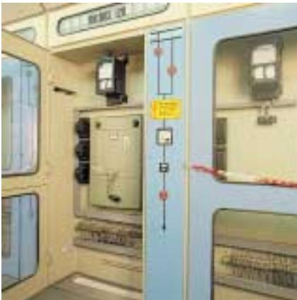
Bild 7a: Vorschriftenmäßig gegen Wiedereinschalten gesicherte freigeschaltete Schaltzelle
