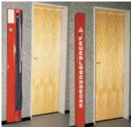
Bild 54: Löschdecke zum Löschen brennender Kleidung
