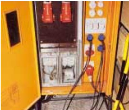
Bild 19: Baustromverteiler
