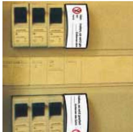
7b: Klebefolie an einem nicht herausnehmbaren Leitungsschutzschalter
