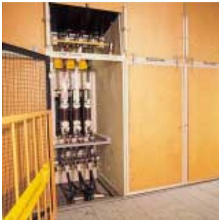
Bild 16: Die eindeutige Kennzeichnung des Gefahrenbereiches hilft Schaltfeldverwechslungen zu vermeiden
