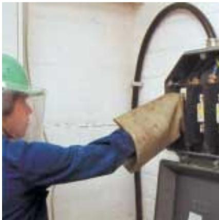
Bild 6a: Monteur beim Ziehen eines NH-Sicherungseinsatzes
