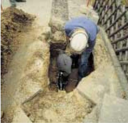
Bild 50: Auch beim Massegießen muss der Massebehälter bis auf die Ausgießöffnung abgedeckt sein
