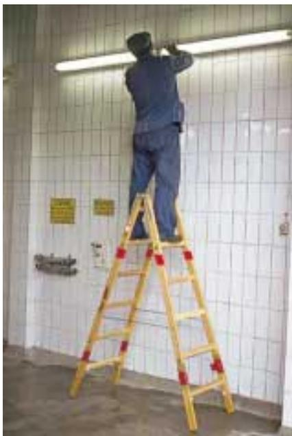
Bild 24: So ist eine sichere Arbeitsstellung auf einer Stehleiter gegeben
