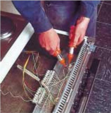
Bild 9: Feststellen der Spannungsfreiheit an der Arbeitsstelle
