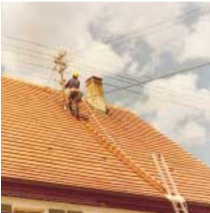
Bild 37: Auf dieser besonders für Dachständerarbeiten konstruierten Leiter steht man sicher
