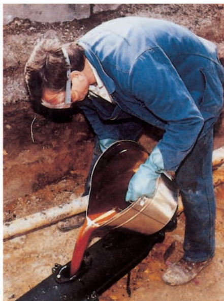
Abb. 2: Einfüllen des Gießharzes in die Muffe
