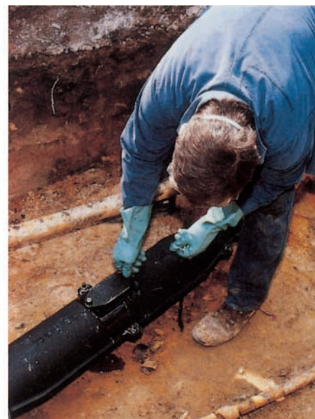
Abb. 3: Schließen des gefüllten Muffekörpers
