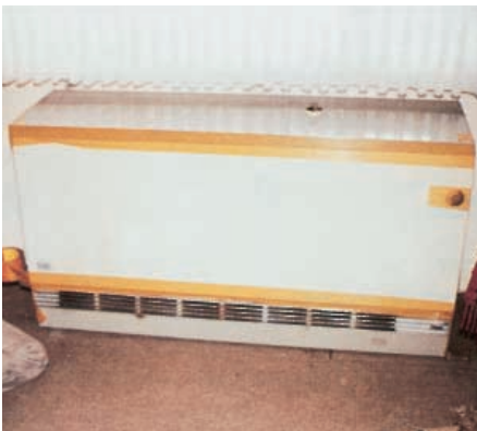
Abb. 1: Staubdichtes Abkleben aller erreichbaren Geräteöffnungen
