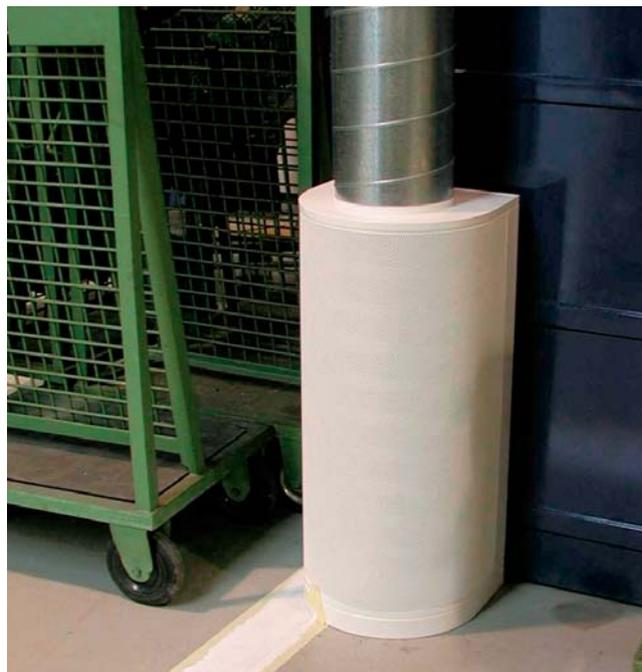
Abb.15: Zuluft durch Quellluftdurchlass
