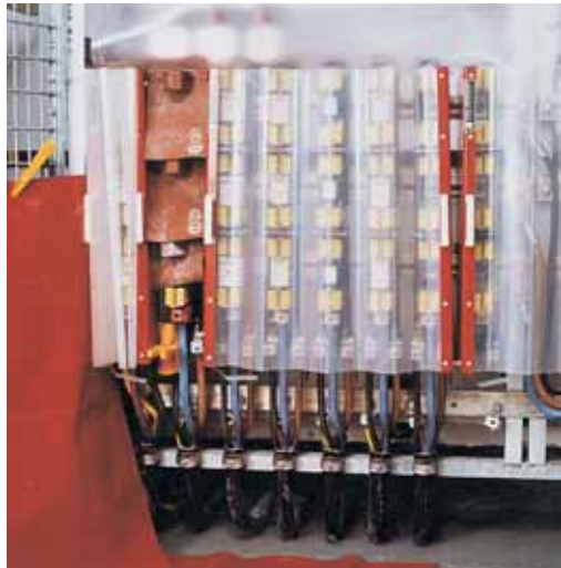
Beim Wechseln einer NH-Leiste darf immer nur ein Potenzial frei sein
