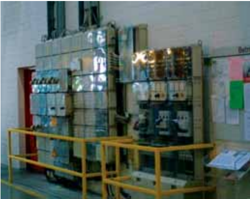
Hindernisse grenzen wirkungsvoll den Arbeitsbereich ein
