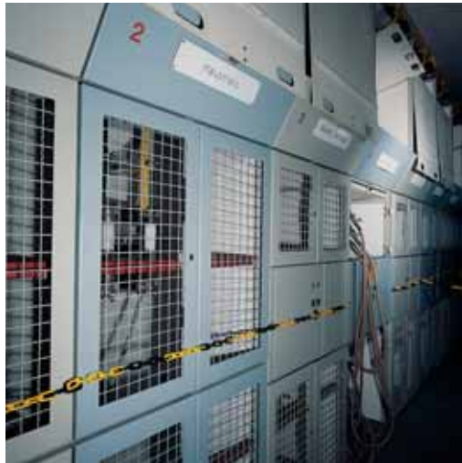
Nur eine eindeutige Kennzeichnung des Arbeitsbereiches schützt vor Verwechslung
