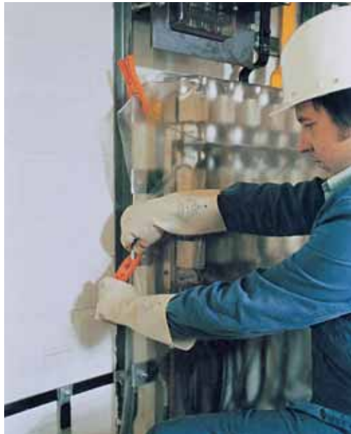
Beim Arbeiten in der Nähe sind die benachbarten Teile gegen zufälliges Berühren abzudecken
