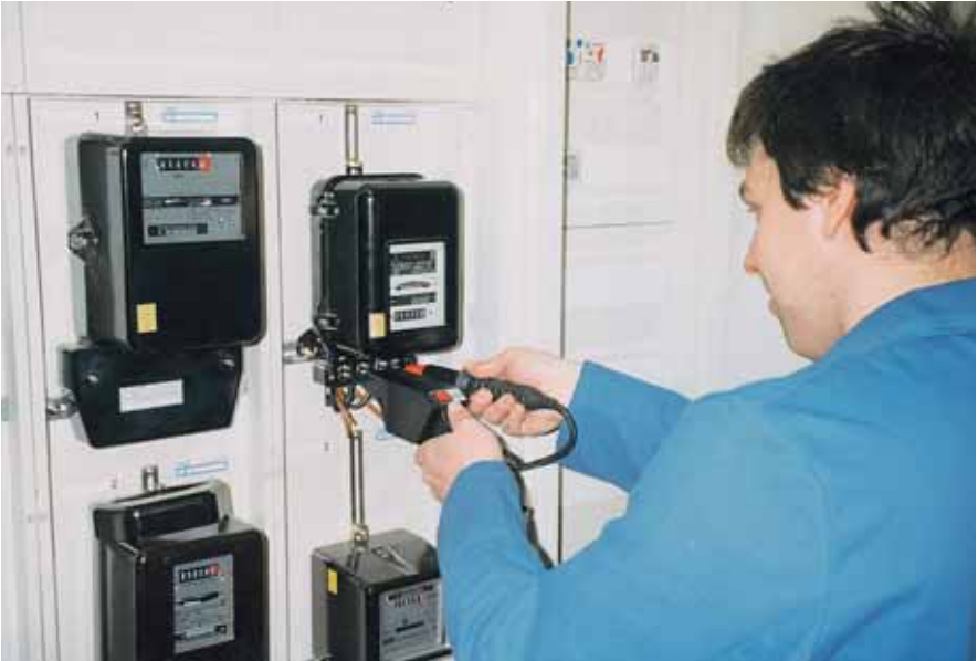
Zähleranlaufprüfung an einem Drehstromzähler
