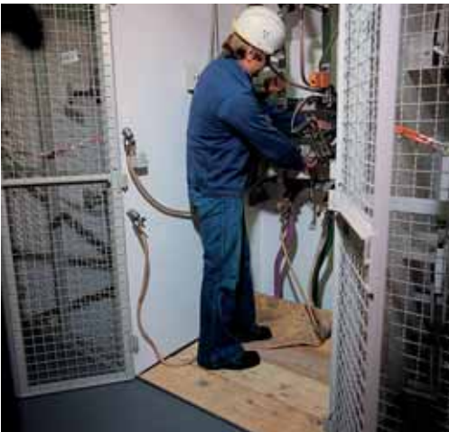
Einlegen der Erdungs- und Kurzschließvorrichtung in einer Mittelspannungsschaltzelle
