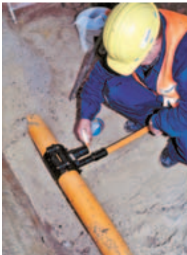
Einbinden einer Hausanschlussleitung
