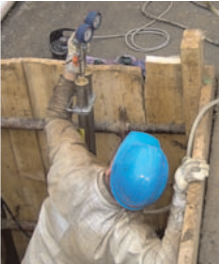
Druckmanometer zur Überwachung des Blaseninnendrucks
