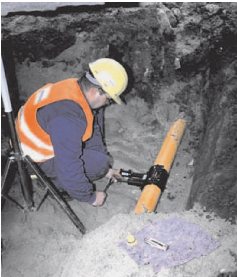
Gasanbohrarmatur für die Erstellung von Hausanschlussleitungen
