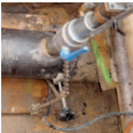
Anschluss einer elektrischen Überbrückung an der Gasleitung
