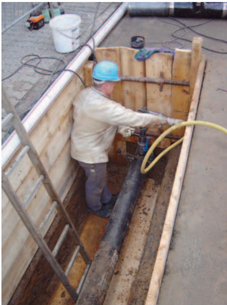
Leitern in der Baugrube dienen zum schnellen Verlassen der Baugrube
