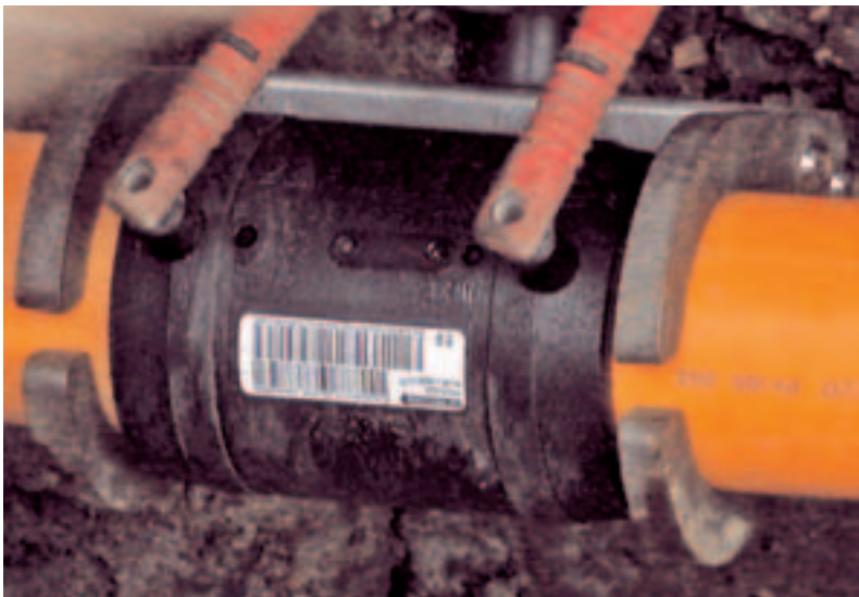
Heizwendelschweißen an einer Polyethylen-Gasleitung
