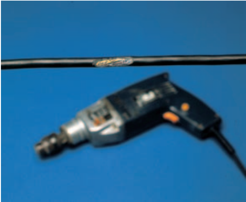
Schadhafte Anschlussleitung an Elektrowerkzeug, sofort der Benutzung entziehen
