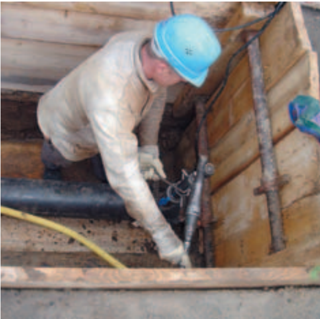
Schleusenbohrgerät zum Anbohren einer Gasleitung
