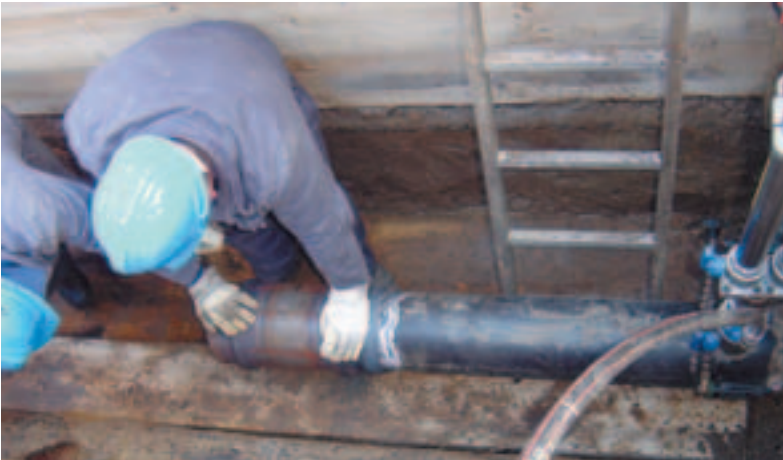
Arbeiten an einer Versorgungsleitung
