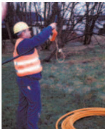
Begasung einer Hausanschlussleitung über eine Schlauchleitung ins Freie
