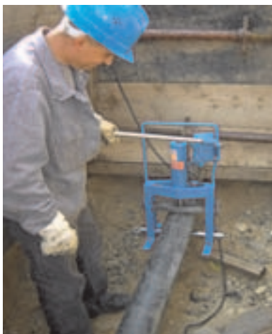
Abquetschvorrichtung für Gasleitungen aus Polyethylen
