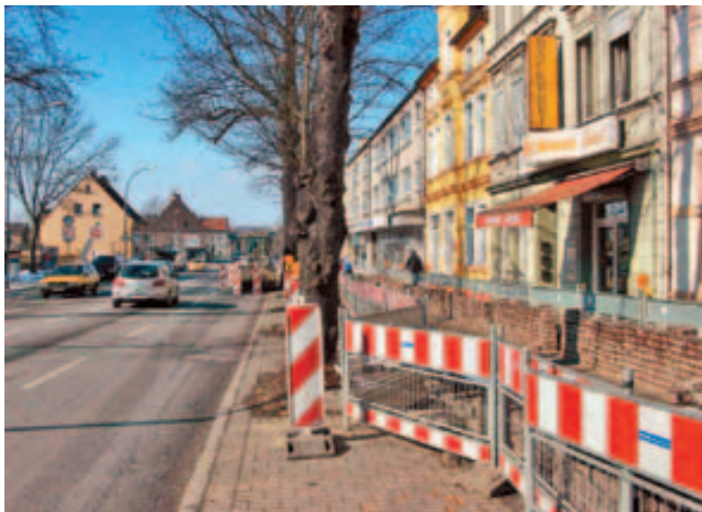
Absicherung einer Straßenbaustelle
