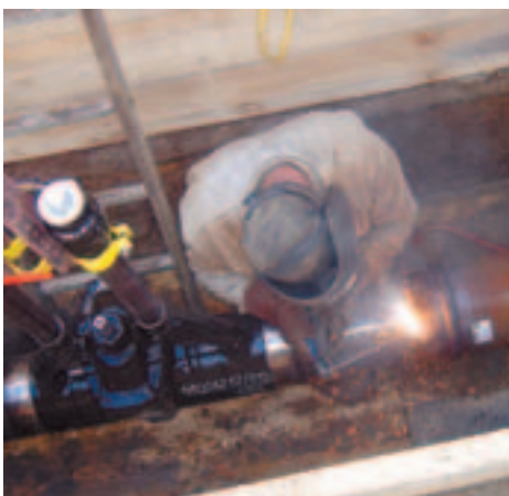
Verschweißen einer Gasleitung mit selbstdichtendem Überschieber
