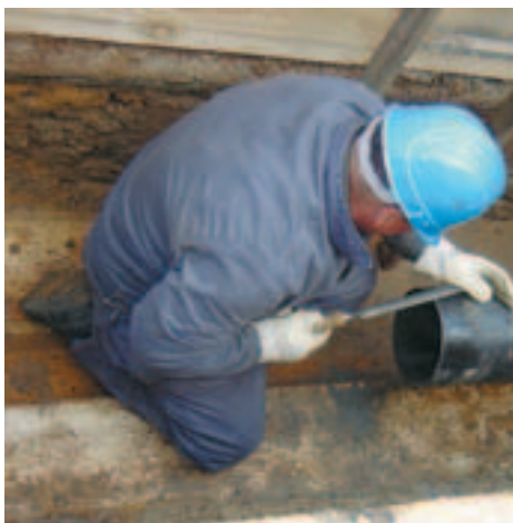
Entgraten der Schnittstelle vor dem Überschieben des selbstdichtenden Muffenüberschiebers
