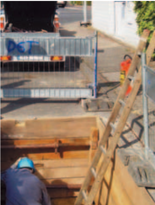
Zugang über eine Leiter in die Baugrube
