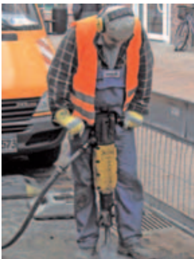
Tragen von Gehörschutz bei Arbeiten mit einem Presslufthammer
