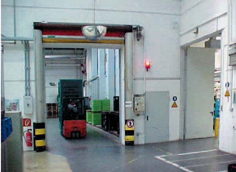
Abb. 80: Gute Hilfsmittelkombination zur Gefahrenreduzierung (Spiegel + Rundumkennleuchte)
