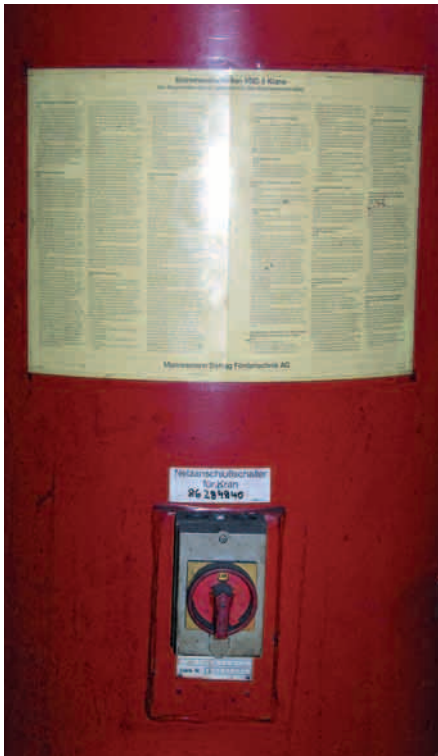
Abb. 53: In der Nähe des Netzanschlusschalters sind die Betriebsvorschriften für den Kranführer jederzeit einsehbar.
