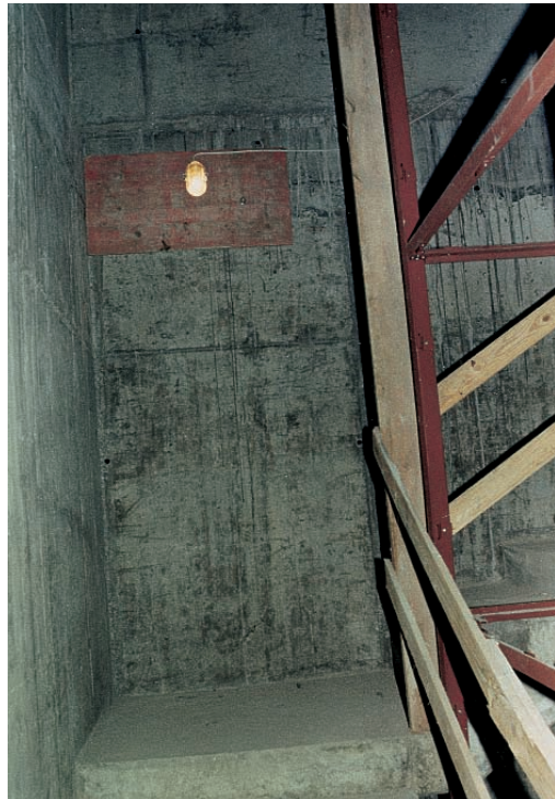
Abb. 2: Provisorische Absturzsicherung im Rohbau eines Treppen- hauses
