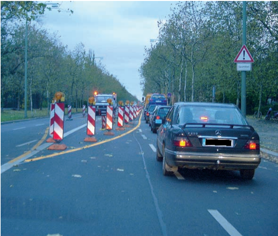
Abb. 1: Absicherung einer Straßenbaustelle
