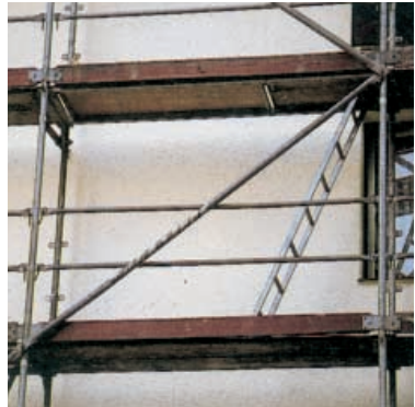
Abb. 11: Leitengang zum Besteigen der Gerüstebenen
