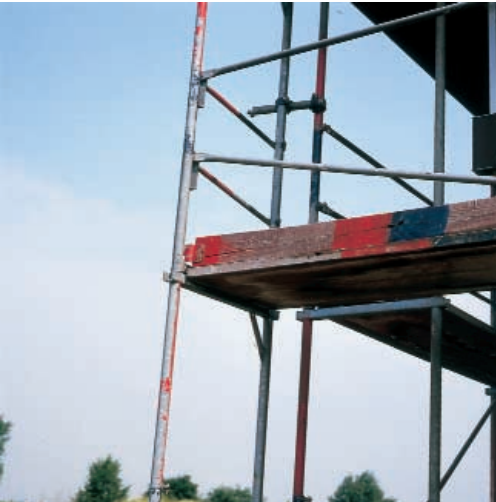
Abb. 10: Vollständiger Seitenschutz auch an Bauwerksecken
