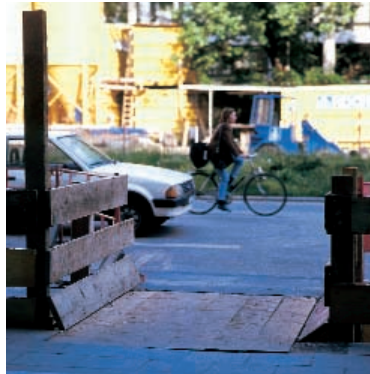
Abb. 18: Übergang ab 0,80 m Grabenbreite und Seitenschutz ab 2,00 m Absturzhöhe
