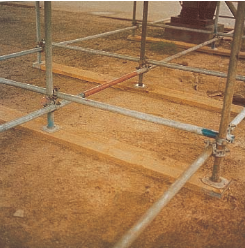
Abb. 8: Unterbaute Gerüstständer
