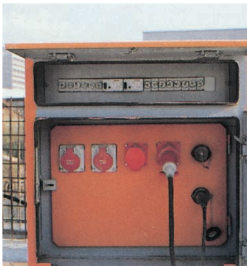
Abb. 23: Vorschriftsmäßiger Baustellenspeisepunkt (Baustromverteiler)
