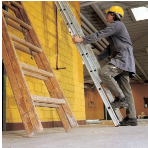
Abb. 7: Stehleitern nicht als Anlegeleitern benutzen
