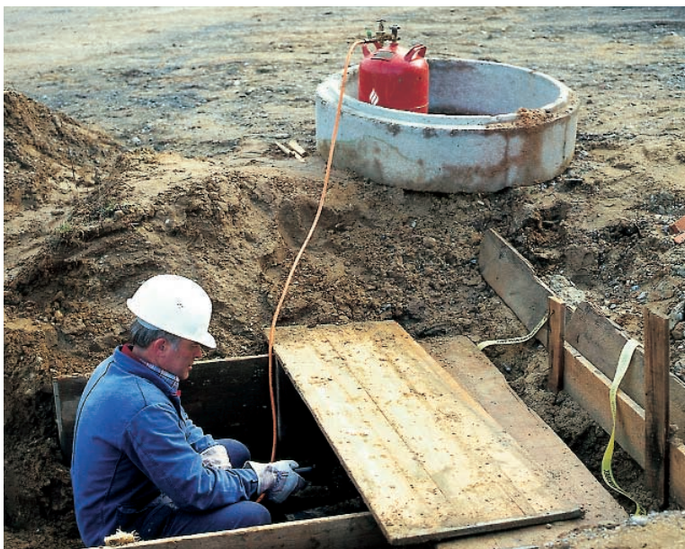
Abb. 20: Umgang mit Flüssiggas in einer Baugrube
