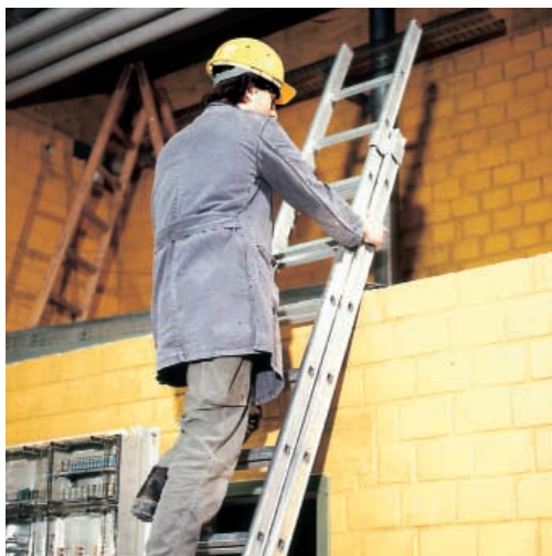
Abb. 6: Leiter muss Austrittsebene um mindestens 1,00 m überragen.
