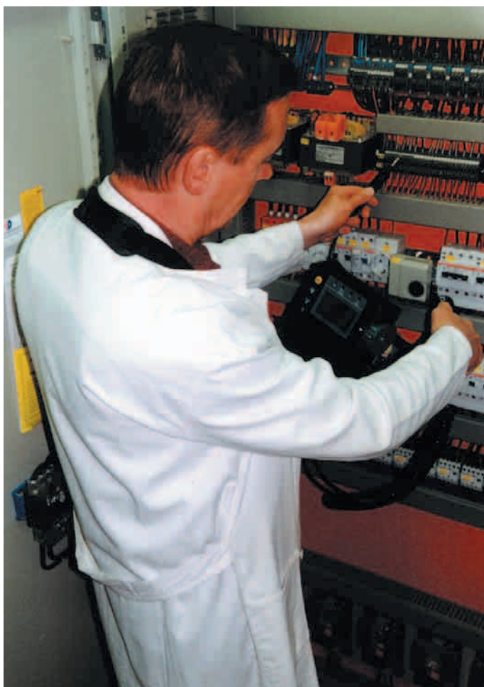
Bild 2: Messung des Isolationswiderstandes nach DIN VDE 0100-610 (VDE 0100-600)
