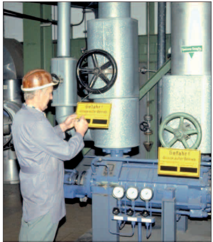
Bild 15: Pumpstation mit der Notwendigkeit einer störungsarmen elektrischen Energieversorgung
