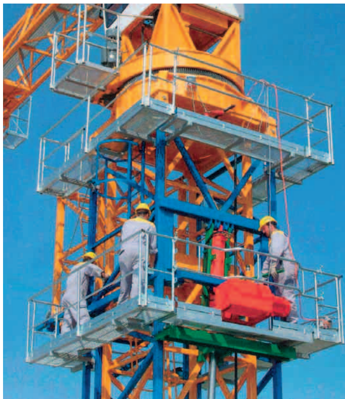
Bild 14: Bau- und Montagearbeiten an einem Arbeitsmittel. Notwendige Prüfungen nach der Montage und vor der Inbetriebnahme.
